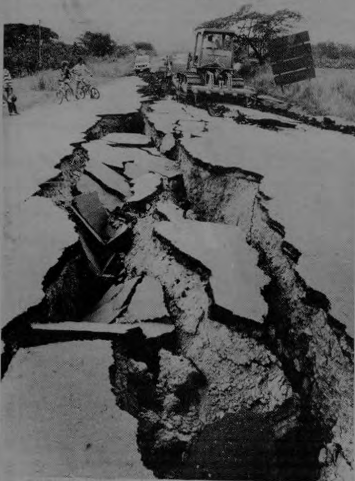
Arreglos provisionales mantienen la carreta a Limón transitante aunque en muy mal estado; se espera que en 1992 sea totalmente restablecida a las condiciones de siempre.
