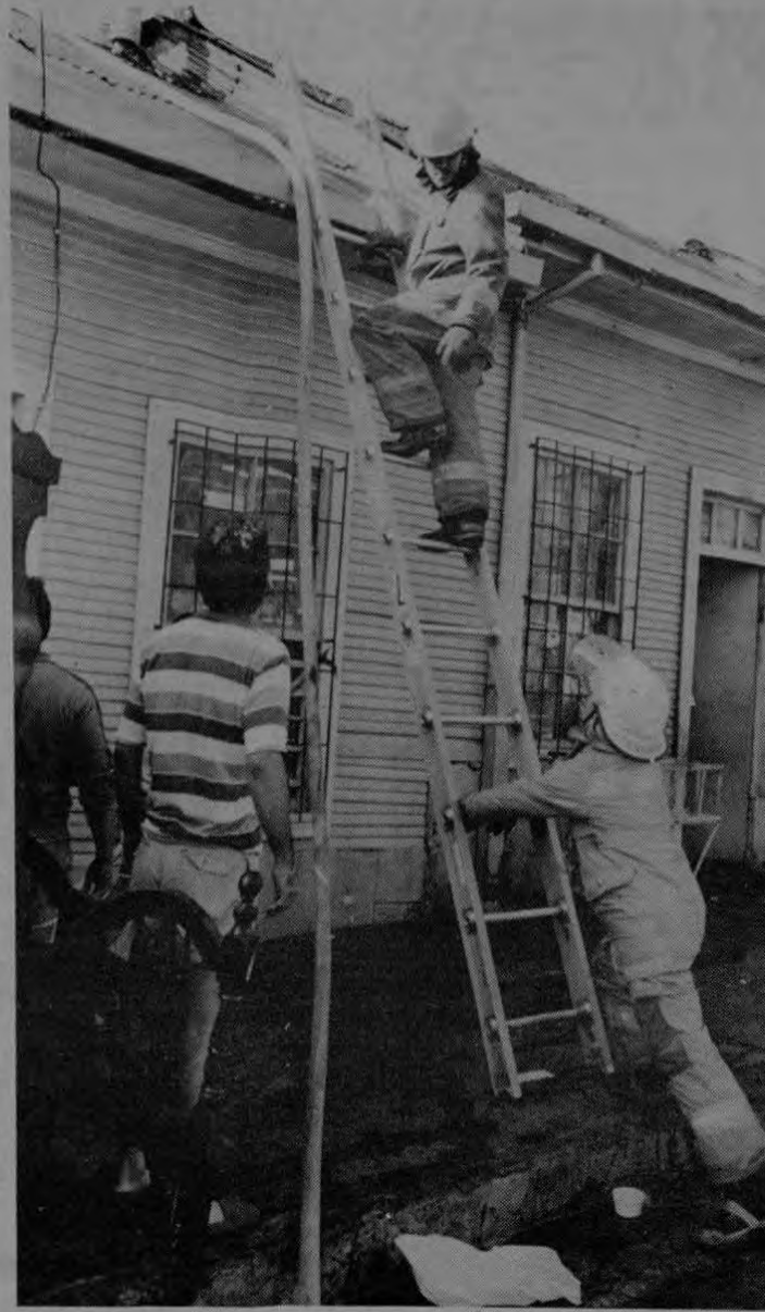
Tres viviendas afectadas parcialmente y una destruida fueron el resultado de un siniestro que ayer en la mañana alarmó a los vecinos del Barrio Cristo Rey. (Castillo)
